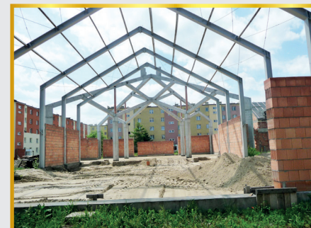
2011 rok - utwardzanie podłoża
