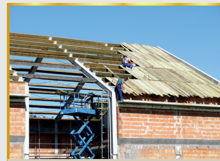
2013 rok - pokrywanie dachu deskami
