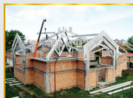
2012 rok - konstrukcja dachu
