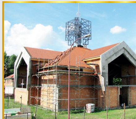
2014 rok – krycie dachu dachówkami
