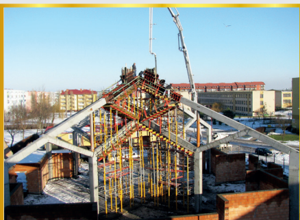
2011 rok - stawianie konstrukcji
