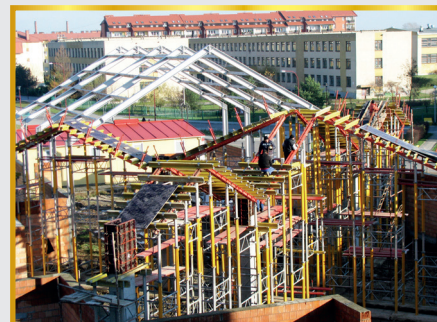
2010 rok - montaż konstrukcji
