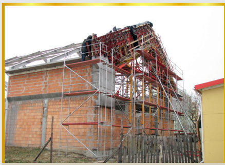
2012 rok - konstrukcja dachu
