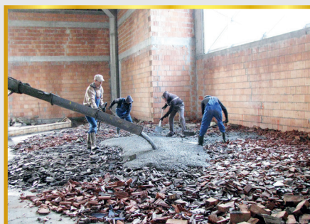
2016 rok – betonowanie prezbiterium
