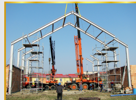
2010 rok - stawianie konstrukcji
